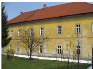
Bürogebäude vor Sanierung © KSW
